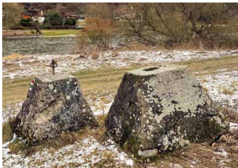
Betonové patky sloupů elektrického vedení, pozůstatek nacistického záboru kraje
