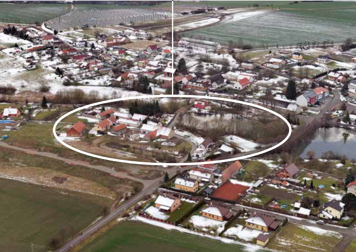
Břežany (za 2. světové války Breschan), část obce Lešany v okrese Benešov. V elipse naznačeno místo někdejšího pracovně-výchovného tábora. Foto Jiří Jiroušek
