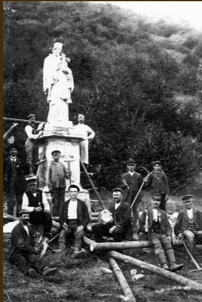
Práce na soše Jana Nepomuckého v roce 1908.
