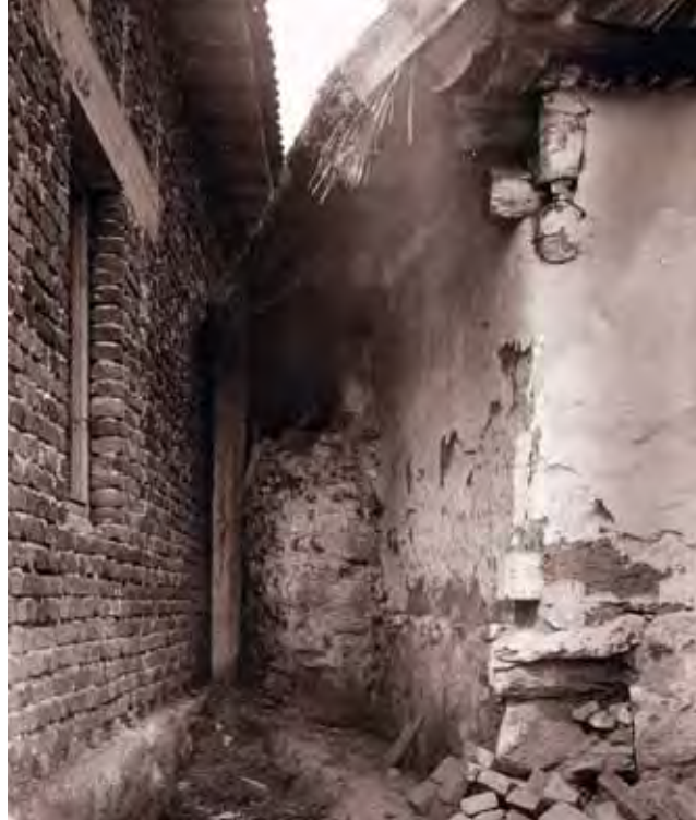
Vysoký Újezd – stavení čp. 17, obecní úřad, zadní boční stěna, pravděpodobně 1942, Státní fotoměřičský ústav v Praze
