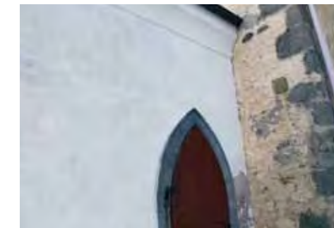
Ukázka původního gotického okna
