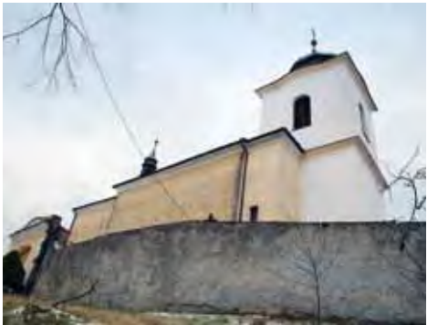
Středověká obranná zeď kolem kostela
