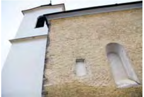
Pravděpodobný vstup na tribunu, ke kterému mohlo vést v minulosti dřevěné schodiště
