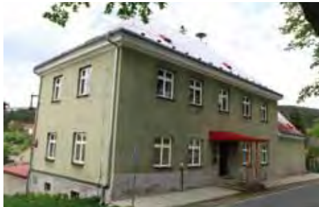
Nově opravená původní škola
