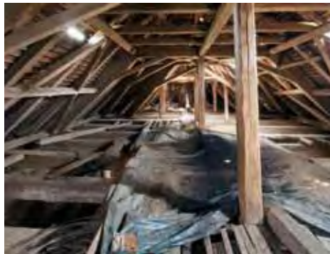
Vysoký Újezd – krov lodě kostela
