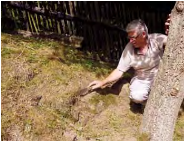
Václav Šmerák při ohledání základů Teletínské tvrze
