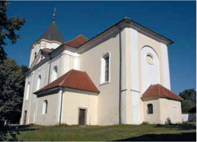
Katolický kostel Nanebevzetí Panny Marie v Netvořicích
