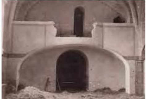
Foto vystěhovaného kostela v roce 1945, tribuna již v pozdější barokní úpravě
