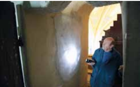
Zazděný vchod do chodby uvnitř věže z prostor za současnými varhanami – z empory kostela, na fotu J. Kloubský, který se po celá léta o kostel pečlivě stará společně s paní Zdenou Šebánkovou
