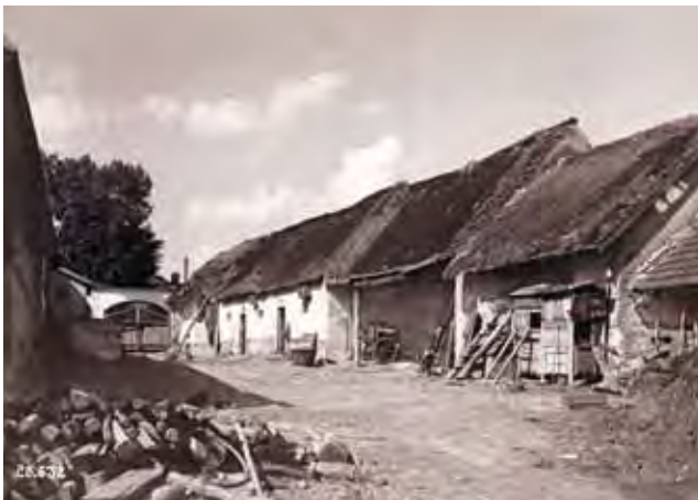
Vysoký Újezd – stavení čp. 8, hospodářský dvůr, pravděpodobně 1942, Státní fotoměřičský ústav v Praze
