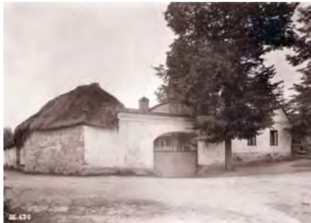
Vysoký Újezd – stavení čp. 8, brána do dvora, pravděpodobně 1942, Státní fotoměřičský ústav v Praze
