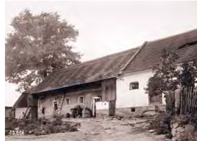
Vysoký Újezd - stavení čp. 3, hospodářský dvůr - chlévy, pravděpodobně 1942, Státní fotoměřický ústav v Praze
