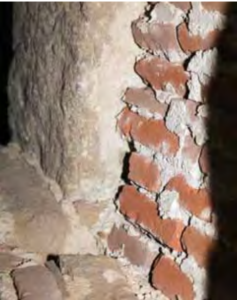
Zazděný otvor do původní schodiškové chodby
