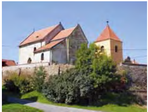
Kostel sv. Bartoloměje v Třebovle je ukázkou rané gotické architektury na českém venkově. Zvonice je mimo stavbu původního kostela (Wikipedia)
