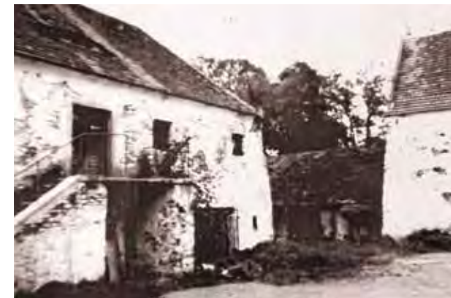
Tvrz Nedvězí, část zástavby poplužního dvora, stav v devadesátých letech
