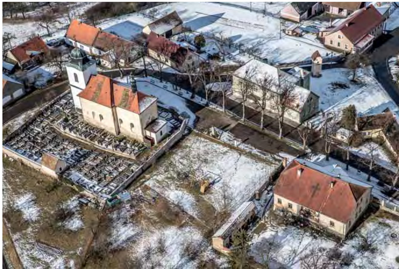
Vysoký Újezd, volná plocha mezi kostelem a farou je nejspíš pozůstatek po újezdském tvrzišti. Na konci 19. století zde byly ještě patrně rozvaliny středověké stavby. Foto Jiří Jiroušek
