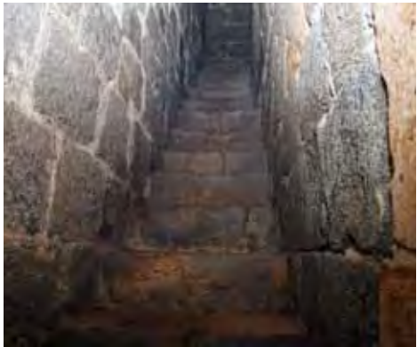
Hrad Týnec nad Sázavou, románské schodiště věže
