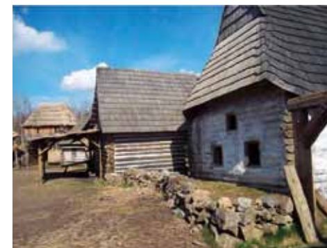
Obytná stavení – rekonstrukce 13. století. Skanzen Řepora.
