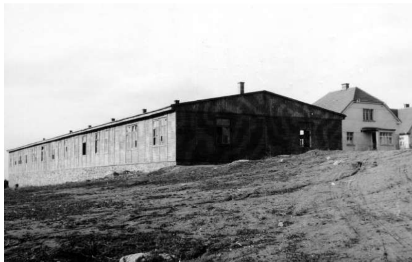
Vojenské ubytování. Velký počet cvičících vojáků si na různých místech cvičiště vyžádal stavbu dřevěných baráků
