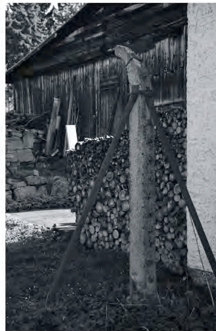
Původní betonový sloupek, v pozadí marodka, foto V. Pavelčík
