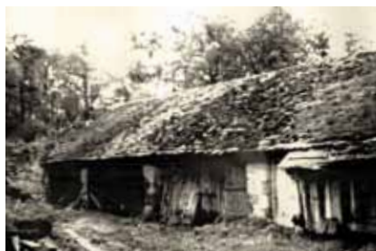
Původní hospodářské budovy tvrze Nedvězí
