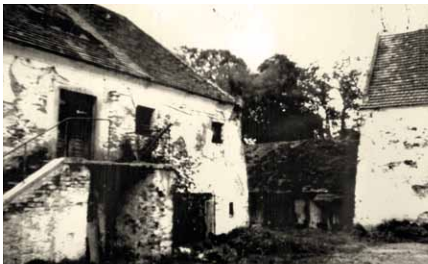
Původní obytná část tvrze Nedvězí. Fota na celé straně – archiv Farma Michael
