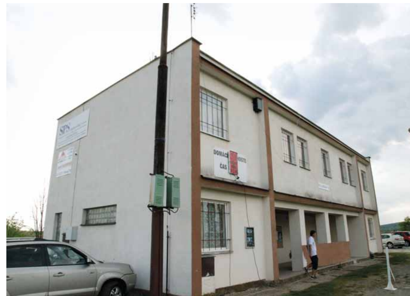
Stav po úpravách v roce 2014
