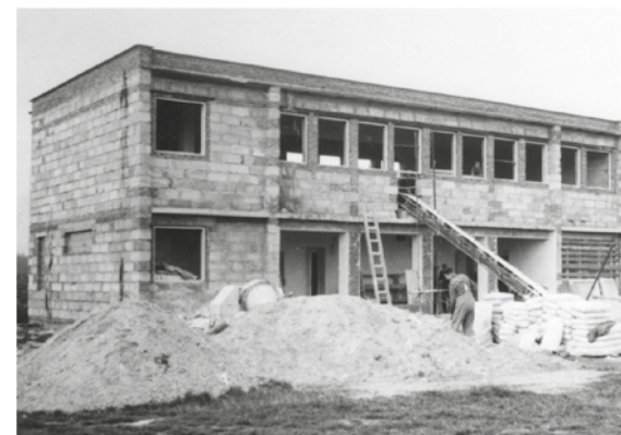
Kabiny s klubovnou a tělocvičnou TJ Krňany před dokončením. Stavba v Akci Z za pomoci občanů Krňan a členů jednoty.
