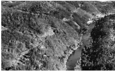
Údolí Sázavy, na úbočí trať železnice
