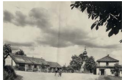
Hotel a restaurace U Novotných - Třebsín
