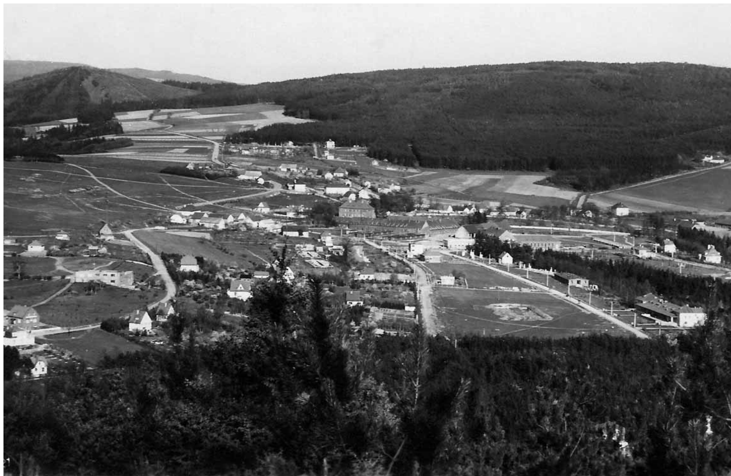
Vpravo v popředí je dobře vidět důstojnické kasino, tzv. Führerheim, naproti přes silnici rozestavěný bazén/koupaliště. Foto z roku 1946 pořídil Josef Dvořák z Davle, archiv Lucie Hašková.
