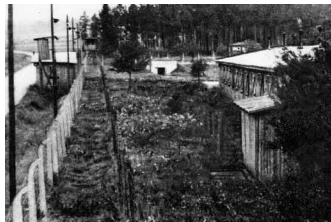
Dvojí plot nedával vězňům možnost útěku. Podél silnice vedoucí do Pikovic jsou patrné betonové základy oplocení.
