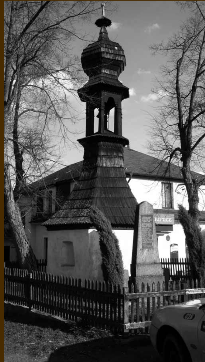
Kaplička před rekonstrukcí střechy a kopule a celkovou opravou.
