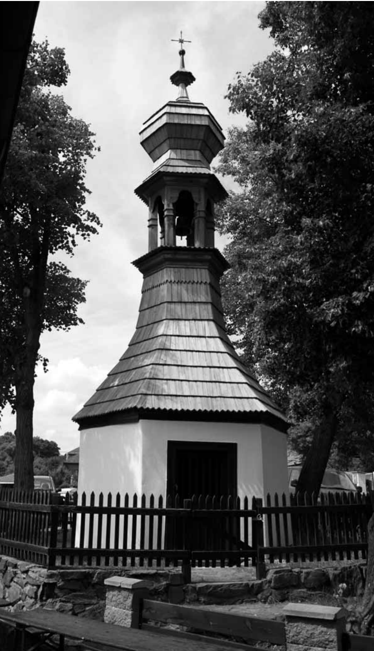
Třebsínská kaplička po opravách v roce 2011.
