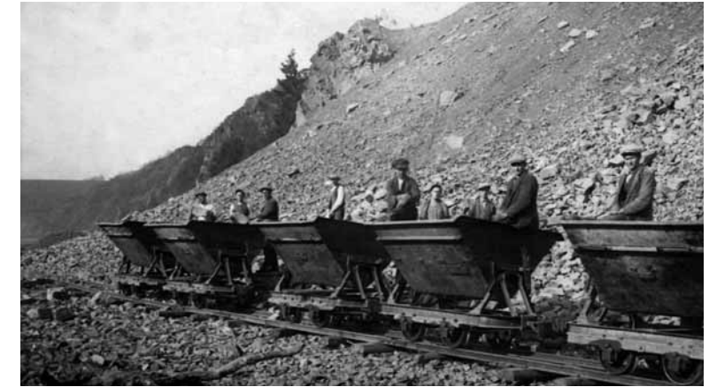
Dělníci při přípravě základů přehrady.
