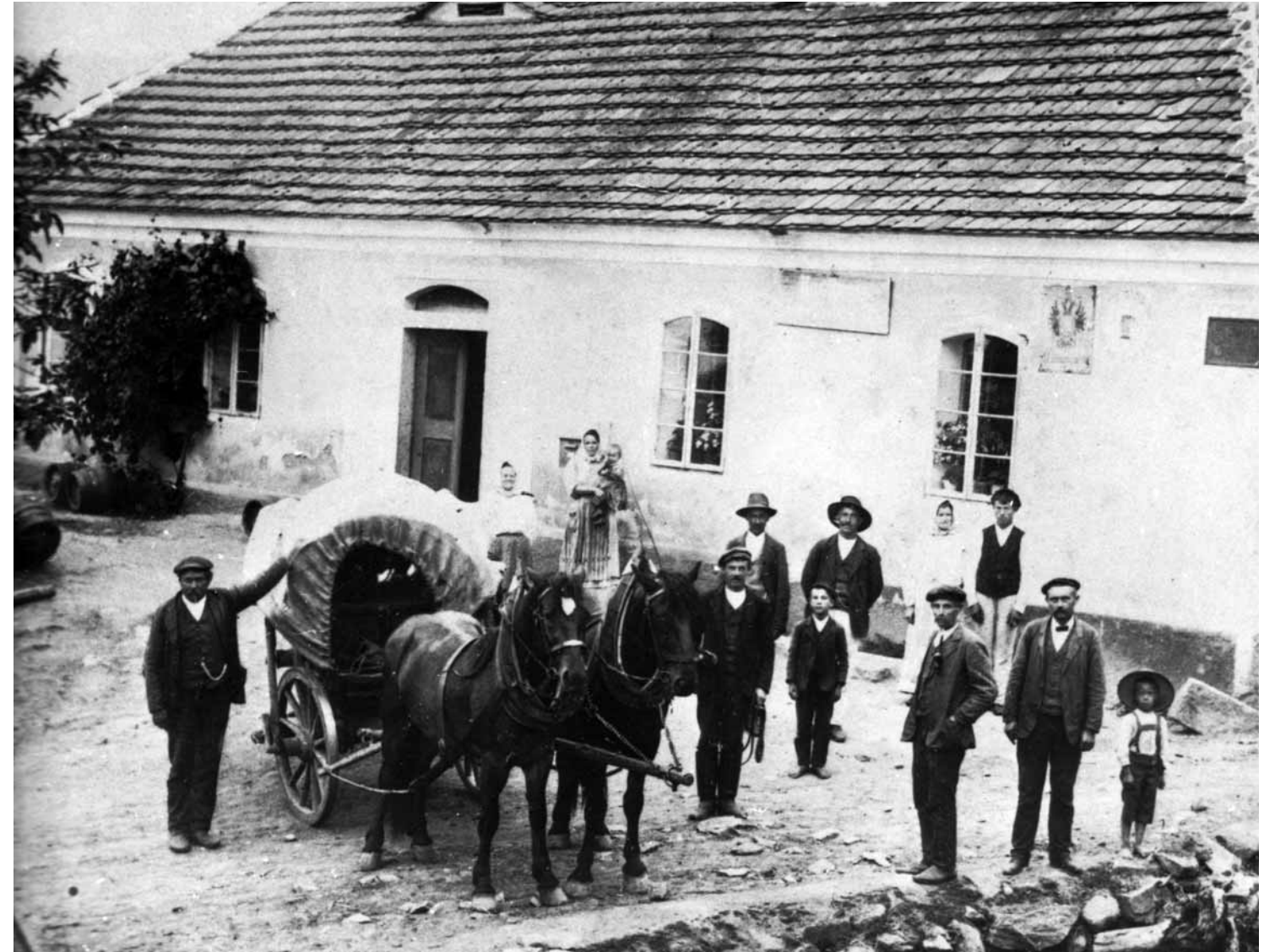
Koňský povoz a občané Teletína před Dvořákovou hospodou v Teletíně. Přelom 19. století.
