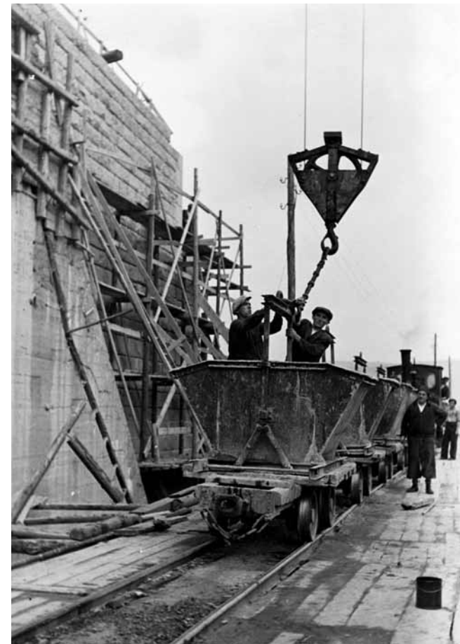
Betonáž Štěchovické přehrady.
