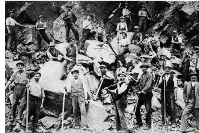
Dělníci budující základy Štěchovické přehrady.
